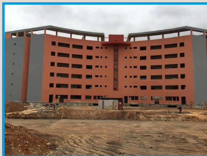
Figure 17. Bâtiments commerciaux et administratifs du Parc industriel de Diamniadio, 12 juillet 2016
