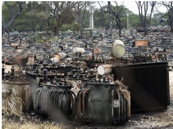
Fotografías 7.1 y 7.2 Almacenamiento de transformadores eléctricos con PCB
