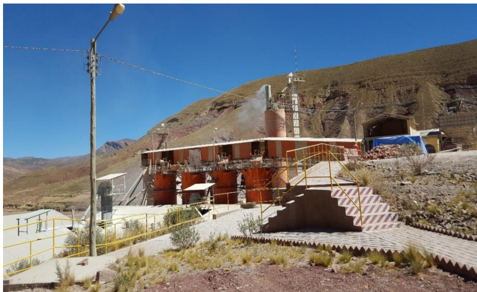
Fotografía 7.6 Fábrica de Cal Cayara (Potosi)
