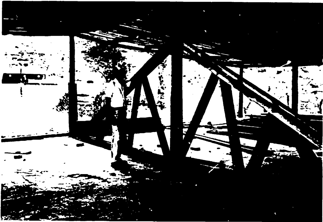
3. Tijeral para el techo del taller de carpintería
