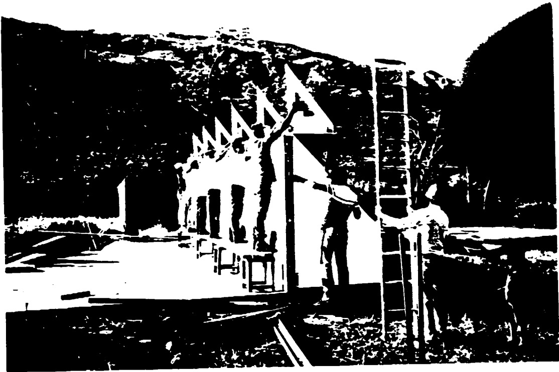
1. Construcción de la secadora solar "Woodmizer"
