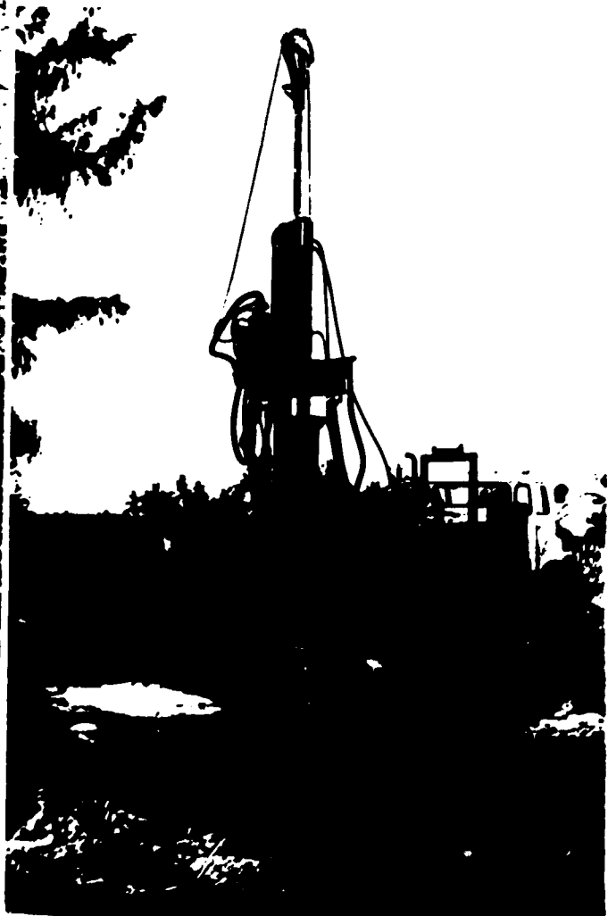
Photo 9 : Travaux de forage du Piezomètre 3.
