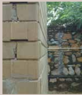
Применение полублоков в углу стены
