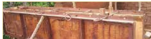
ФОРМОВАНИЕ ФРАГМЕНТА СТЕНЫ ТРАМБОВАНИЕМ ГЛИНЫ В ЩИТОВОЙ ОПАЛУБКЕ
