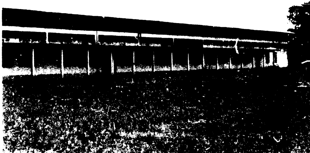
BÂTIMENT TREMPAGE ET FABRICATION DES BOITES
