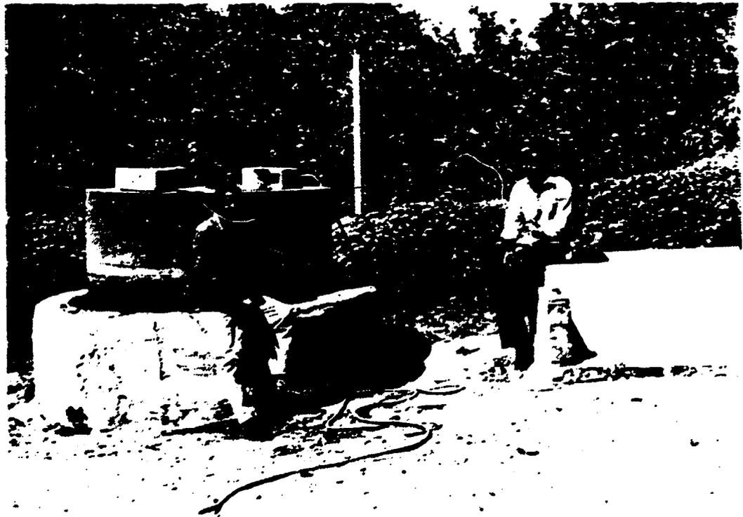
Fig. 2 Le digesteur du type indien sur le domain du Centre de Formation Rurale de Nianing. Le biogaz est utilisé pour la préparation des repas et pour l'éclairage
