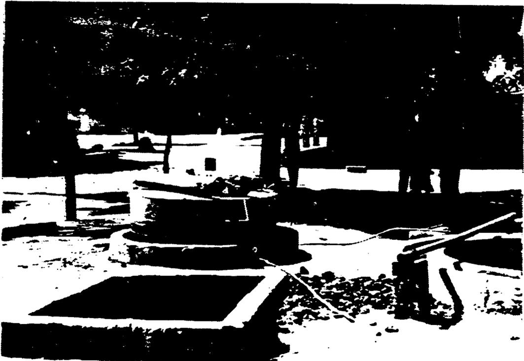
Fig. 7 Le digesteur gazomètre en combinaison avec un digesteur à couvercle fixe (type Voltaïque) à Badiana. Le biogaz est utilisé dans le dispensaire.
