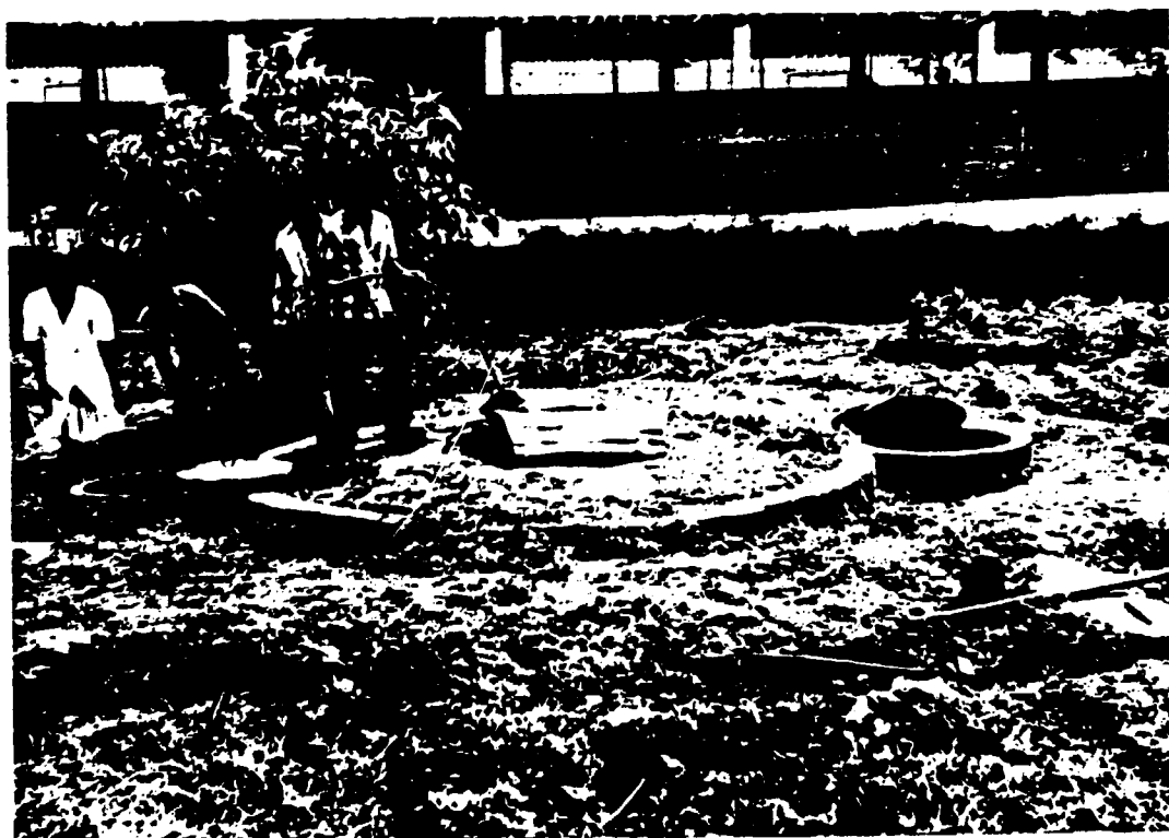
fig. 4 Vue d'un digesteur du type chinois qui marche dans la région de Kipé
