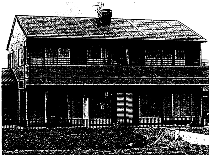
建材一体型実証棟 (高耐久性屋根パネル方式)
