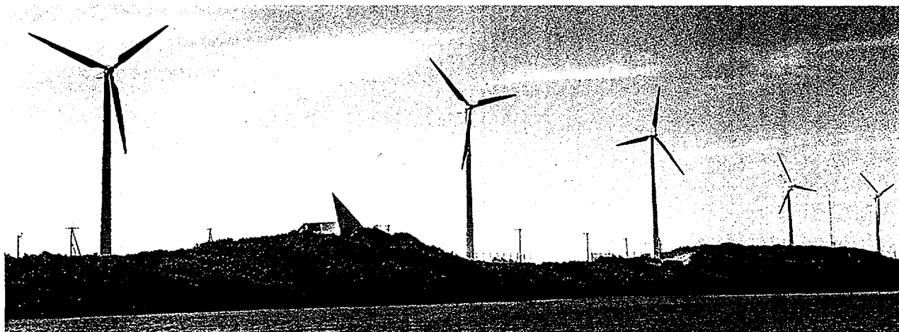
宮古島風力発電システム Wind Power Generation Systems at Miyako Island
