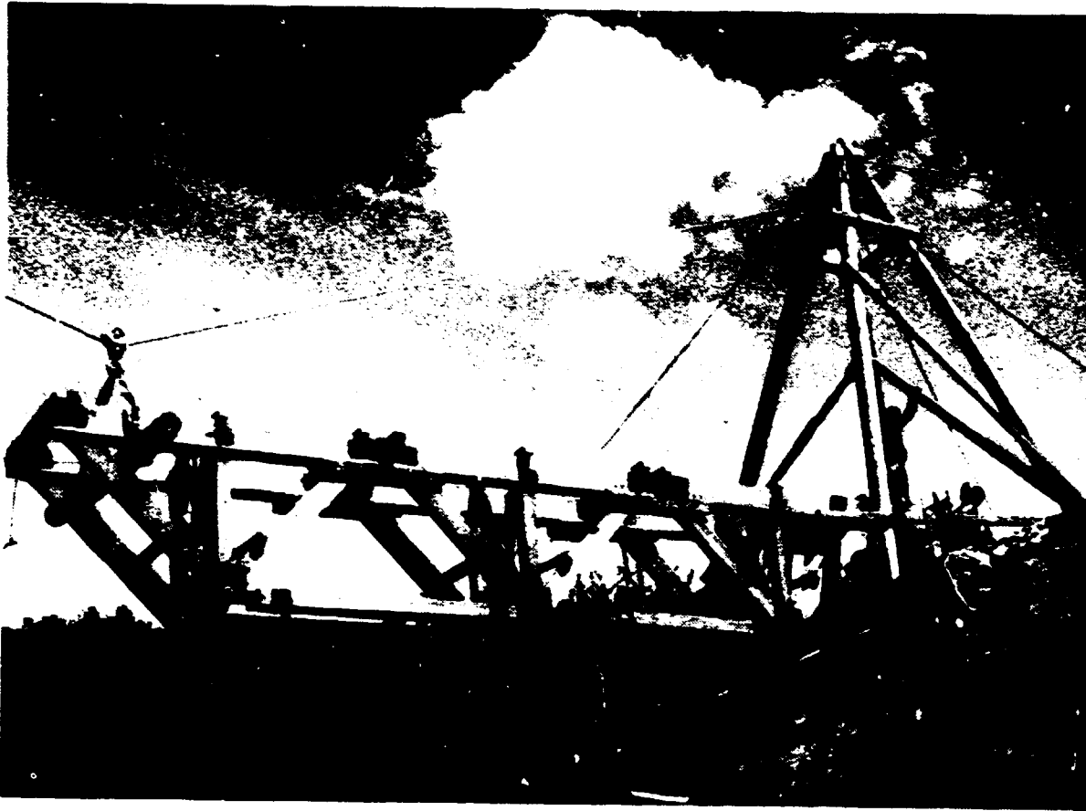
Установка двойной фермы на строительстве деревянного моста из дешевых готовых модульных элементов (Гондурас)
