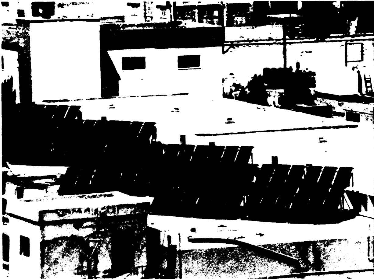
Capteurs solaires fournissant de l'eau chaude à une société laitière à Rusayfa (Jordanie).
