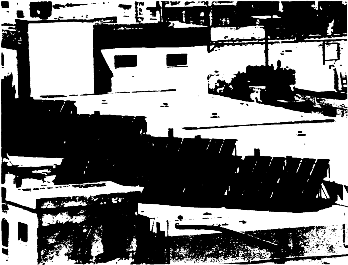
Sistema de paneles solares para abastecer de agua caliente a una fábrica de productos lácteos en Ruseifa (Jordania).
