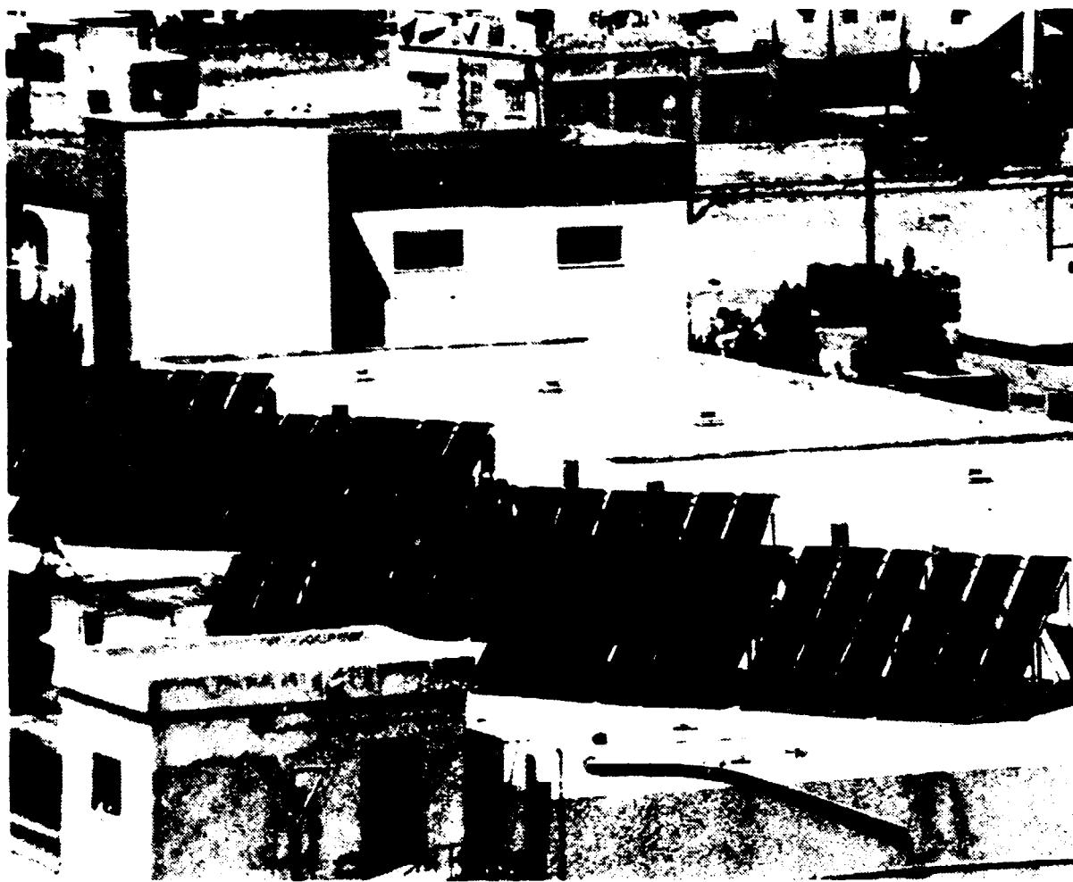
太阳能吸光板为鲁赛法(约旦)的一家奶制品公司提供热水。
