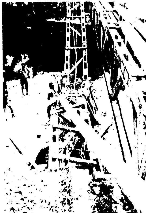
Fig. 13 Collapsed Girder
