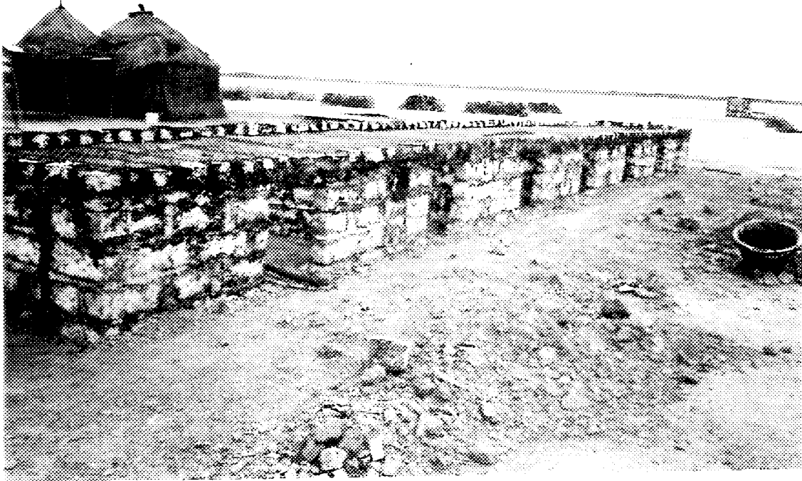
5a) fumoir parpaing construit en matériaux locaux (briques et argile)
