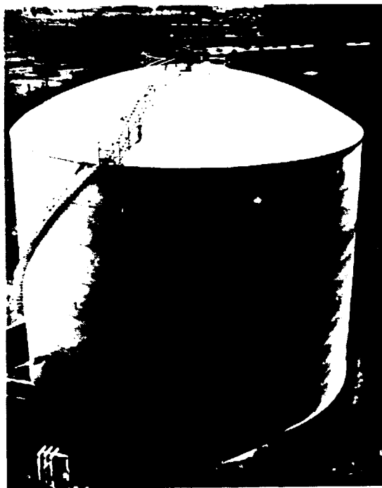
Figure 1. Réservoir de stockage sous la pression atmosphérique
