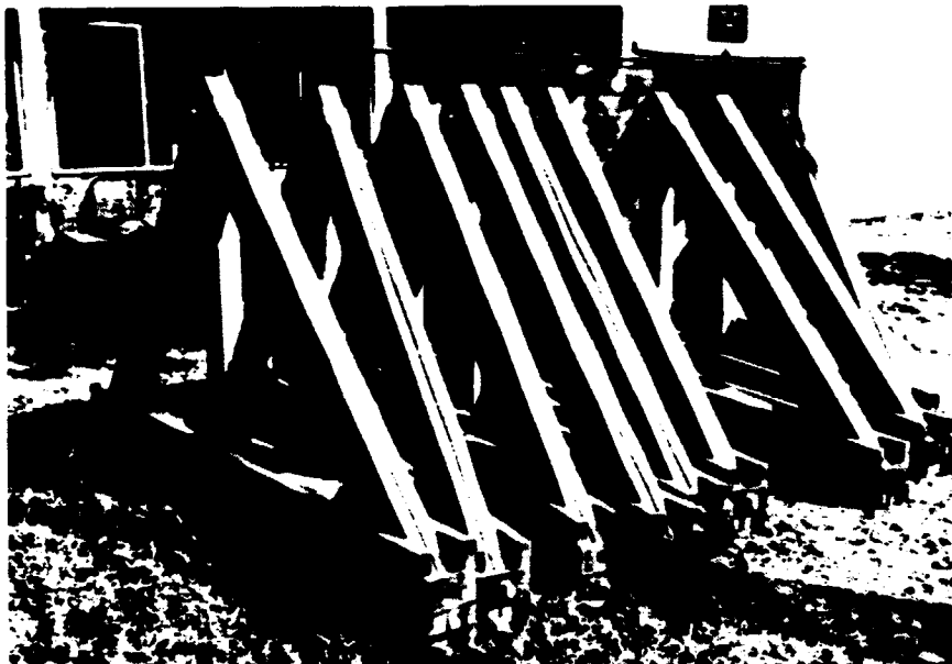
6 - Modules terminés attendent le transport au site
