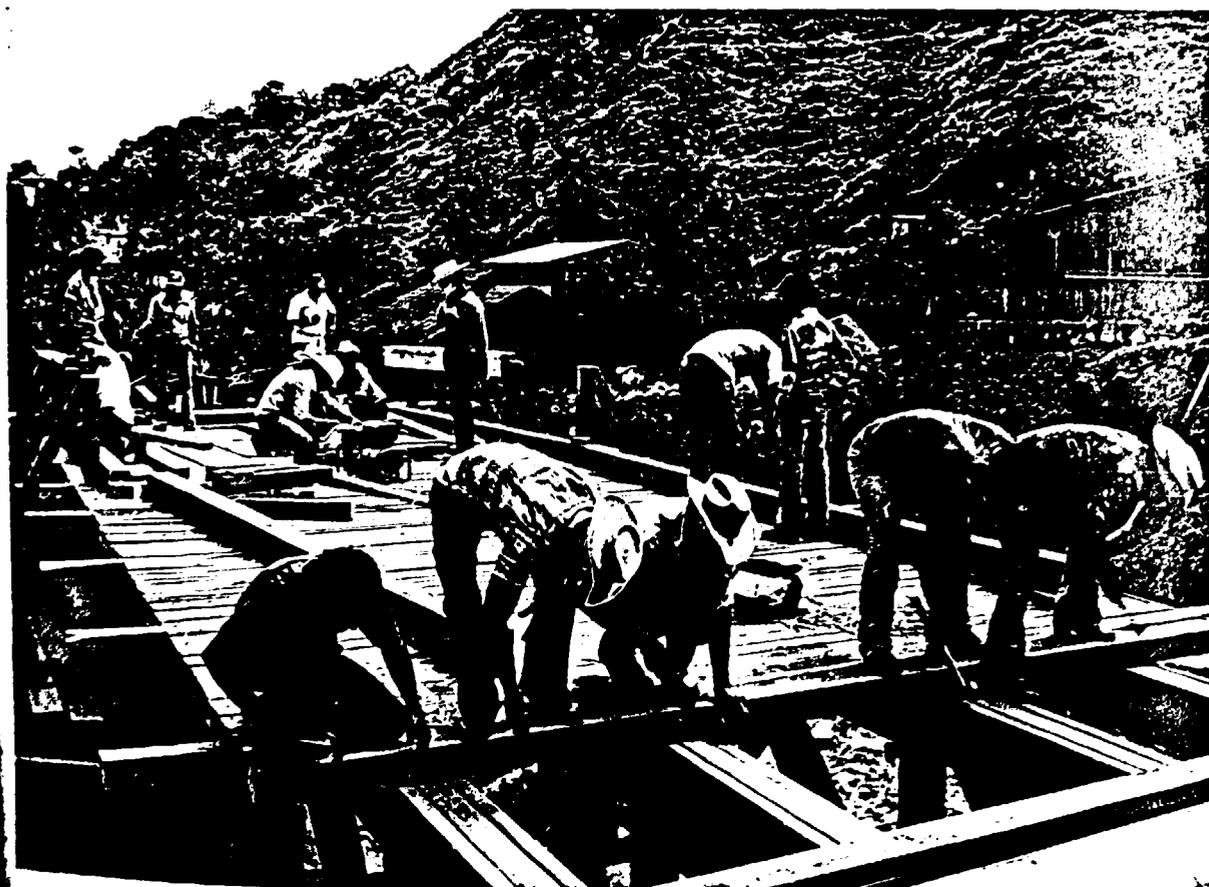
Fotografía 4. Fijado de la cubierta y barandales.
