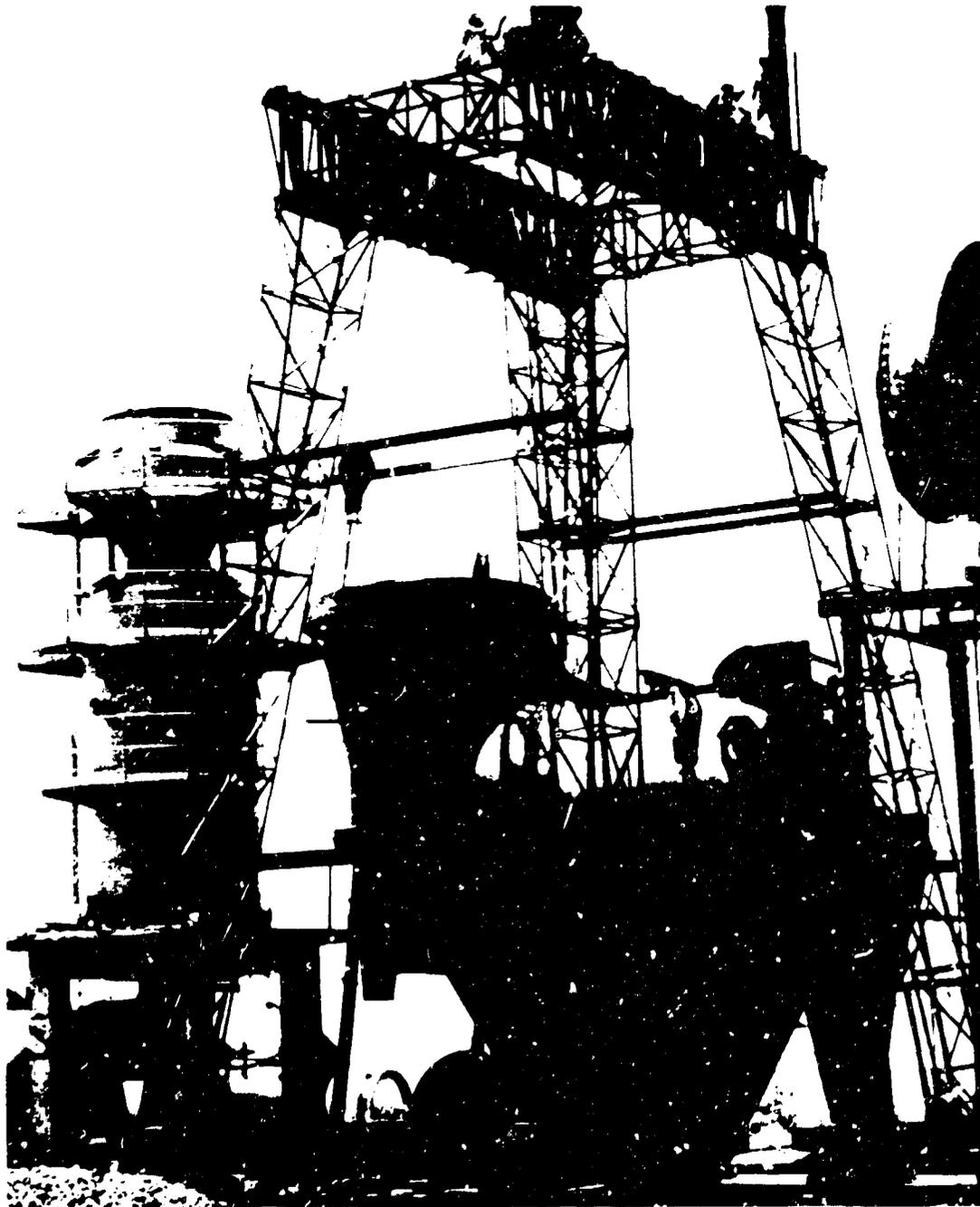
*Installation du brûleur de postcombustion et de la cuve du four rotatif à l'usine de démonstration pour la production d'éponge de fer Andhra Pradesh (Inde)*
