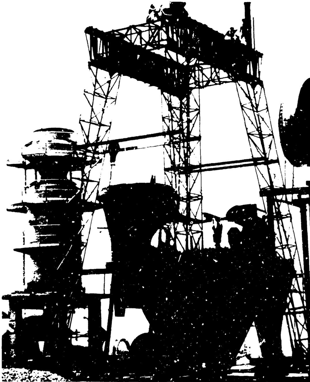
*Instalación de un quemador y chimenea del horno rotatorio para la planta de demostración de esponja de hierro, Andhra Pradesh, India*
