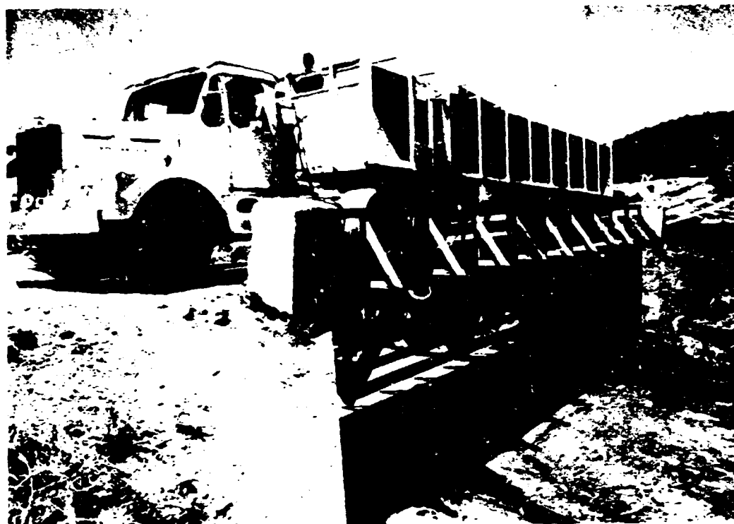
Port en bois modulaire préfabriqué de 15 mètres de long
