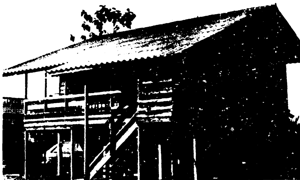
Ecole construite en République démocratique populaire lao selon un système de construction préfabriquée modulaire à bon marché
