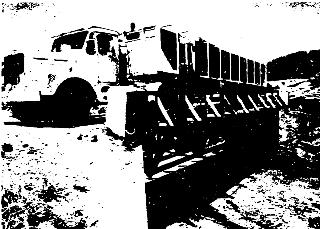
Puente de madera modular prefabricado con una luz de 15 metros
