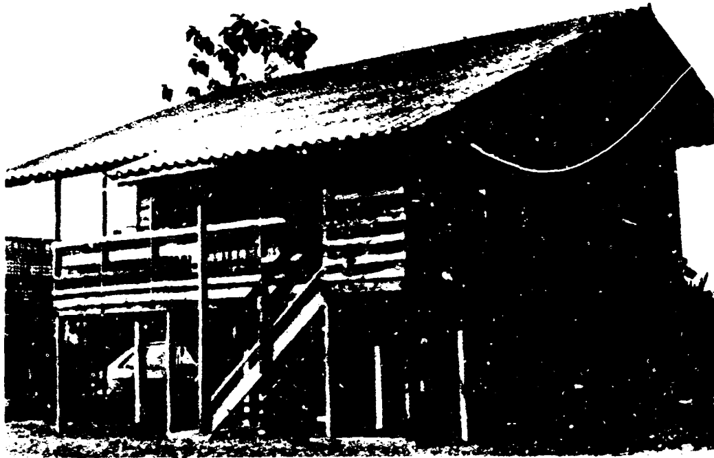
Escuela construida en la República Democrática Popular Lao mediante un sistema de construcción económico con módulos prefabricados
