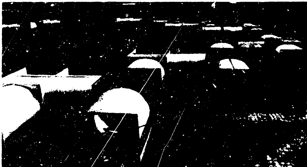
Construction d'un village à l'aide de modules en matière plastique en Equateur
