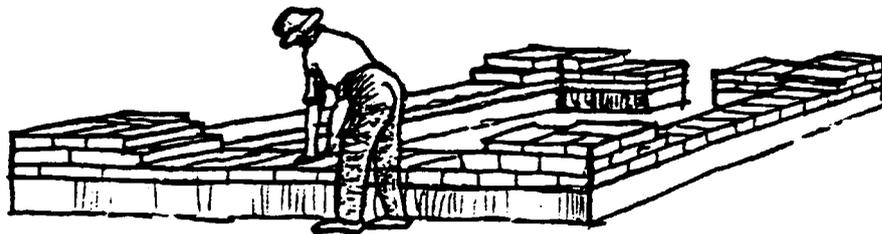
Para evitar el aplastamiento del muro por su propio peso, la altura máxima por día, no debe ser mayor a un metro.
