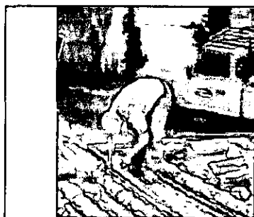
Figura 2.a Preparación de las tuberías del circuito primario
