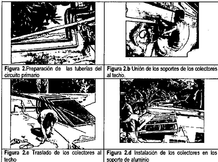
Figura 2. Transporte e instalación de los colectores en el hotel.
