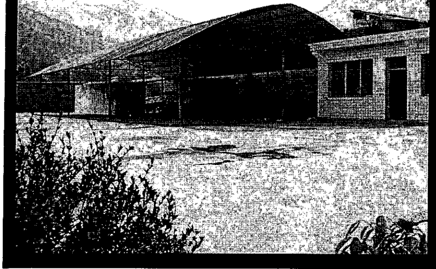
桐梓县甲基溴淘汰育苗示范中心配套设施——储物大棚
