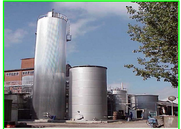
Figura 45. Digestor tipo EGSB
