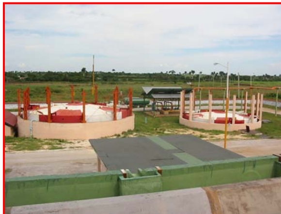
Figura 48. Fase constructiva de la planta UASB para el tratamiento de residuales líquidos
