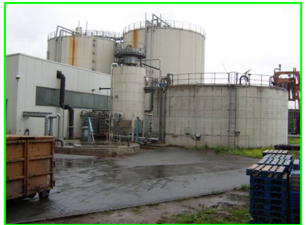
Figura 44. Digestor tipo UASB
