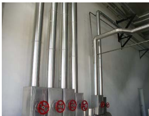
Figura 23. Tuberías aisladas
