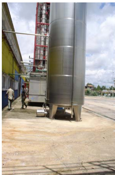
Figura 25. Tanque para la recuperación del concentrado
