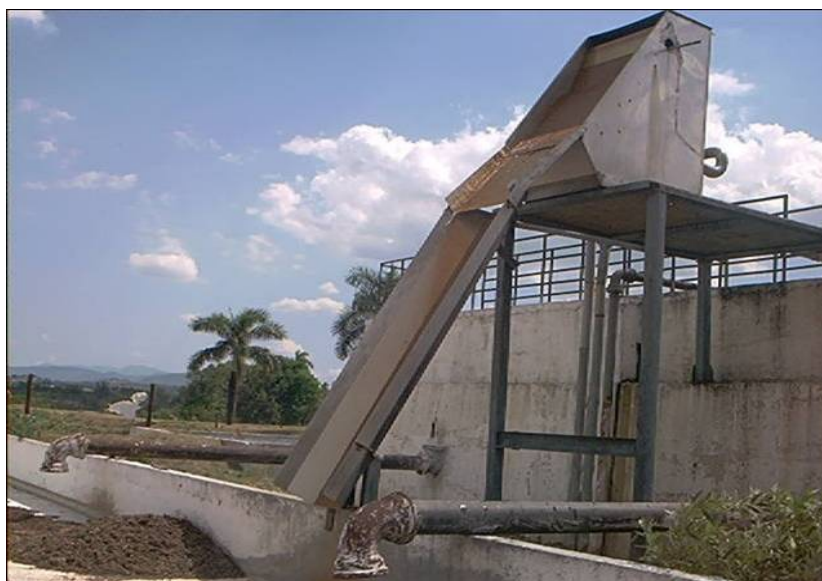
Figura 27. Filtro parabólico para pretratamiento de residuales líquidos cítricos
