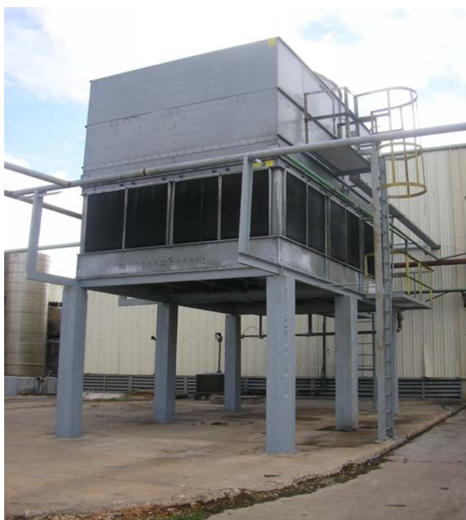
Figura 29. Condensador evaporativo
