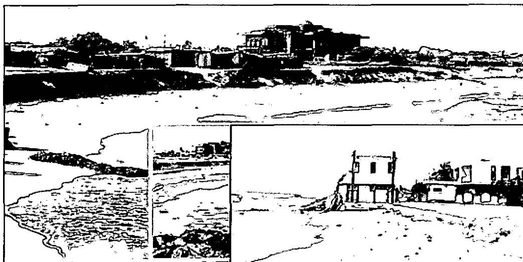
Photo 2 : Destruction de constructions côtières : hôtel Palm Beach en ruine (décembre 2002, DST/FAST)
