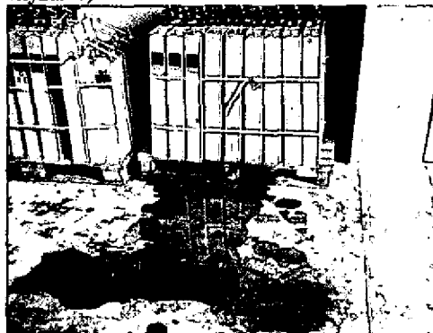
Слика 76: Лош пример II (нема тацни за истекување)
