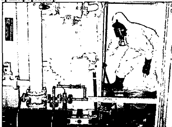
Слика 55: Испуштање на РСВ од трансформатор
