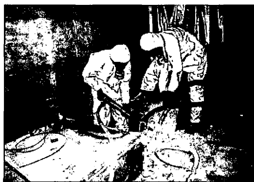
Слика 52: Кршење на контаминиран бетон
