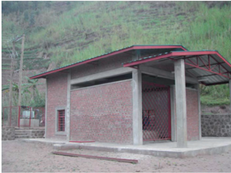
Mutobo (Rwanda): Powerhouse
