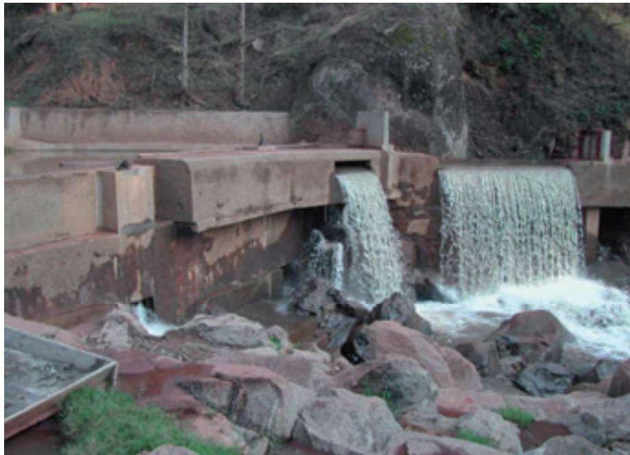
Gatubwe (Rwanda): Weir
