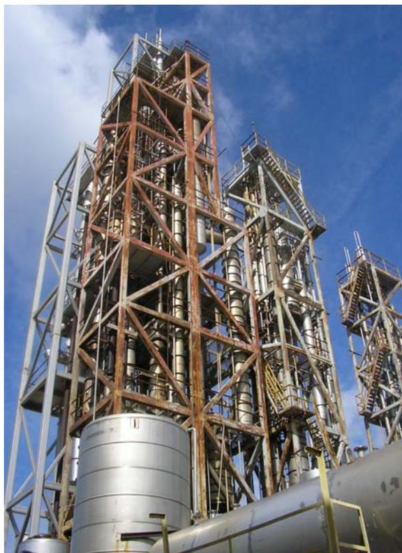
*Figura 18. Tanques para la recuperación del condensado vegetal de los evaporadores*
