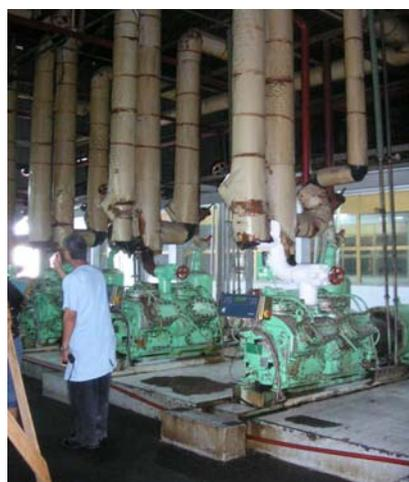
*Figura 28. Aislamiento deficiente de las tuberías que conducen líquidos refrigerantes*
