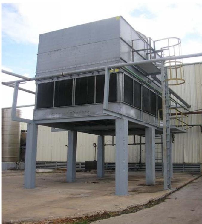
*Figura 29. Condensador evaporativo*
