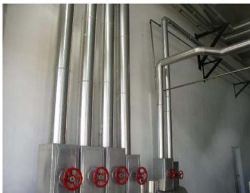
**Figura 23. Tuberías aisladas**
