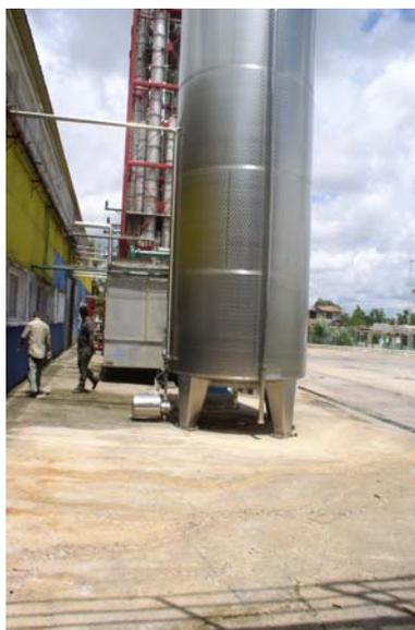
*Figura 25. Tanque para la recuperación del concentrado*
