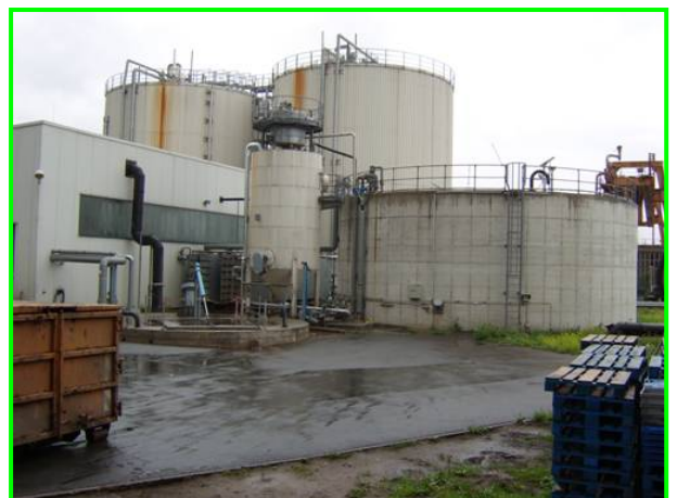
Figura 44. Digestor tipo UASB
