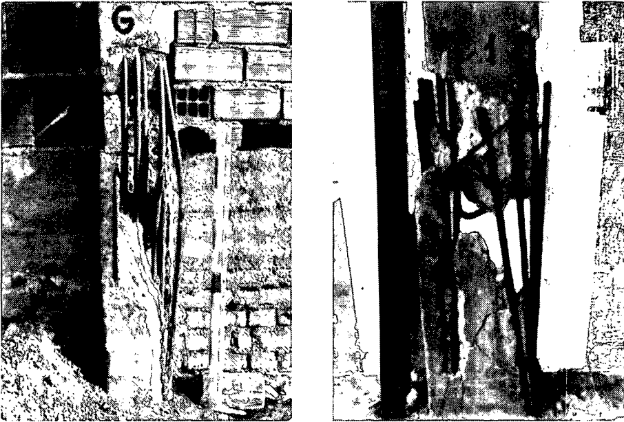
(d) Insufficient ties and insufficient anchorage length
