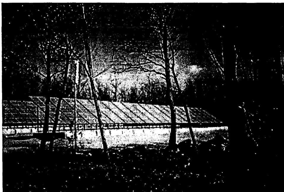
16-Impianto PL V308. Per alimentazione di Passaggio a Livello, installazione in Sicilia. Potenza 1200 Wp--Tensione 120 Volt
