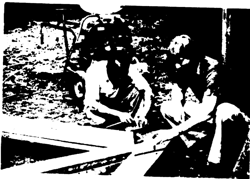
5. Empernado de la chapa triangular de unión en el vértice del elemento
