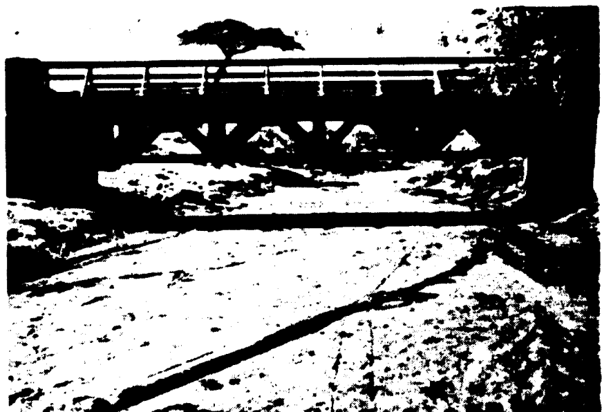
21. Puente terminado (vista lateral)
