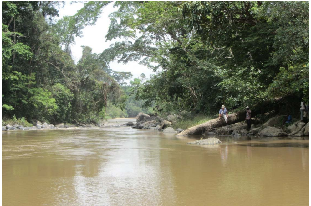
Figure 2-4 : Le possible site du barrage
