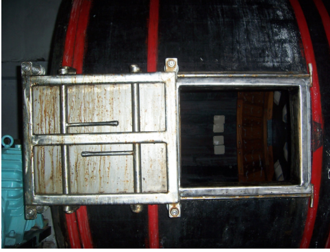
চিত্র: ৫ স্লাইডিং মরিচাহীন স্টীলের দরজাসহ সংস্কারকৃত ড্রাম।
