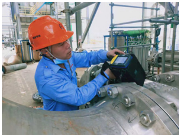
管道安装后组成件及焊缝 PMI、PT 检测
