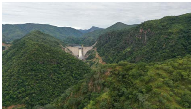
赞比亚下凯富峡水电站（大坝）
