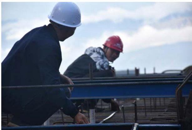
首片梁板顺利浇筑完成
