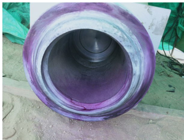
铬钼钢 P91 坡口 PT 检测
