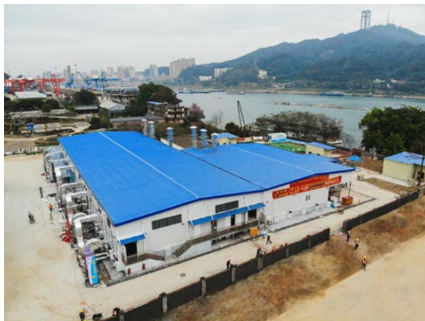
援建梧州市第三人民医院应急医院
