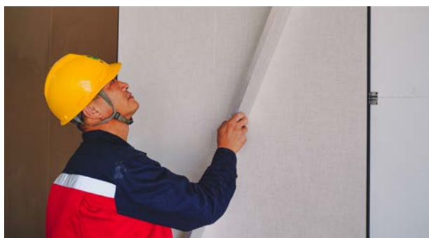
装配式施工作业现场
