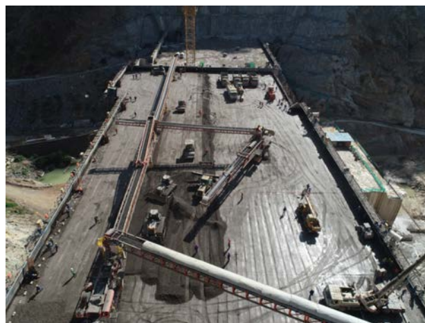
全皮带系统快速连续升仓技术
