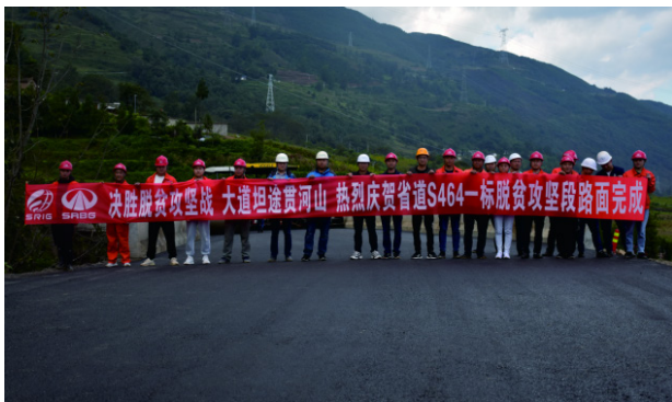
省道S464普格一标项目最后一段沥青路面 碾压成型，满完成“930目标”
