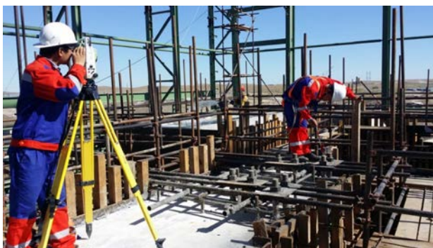
预埋螺栓精准定位
