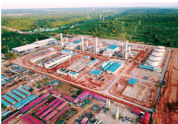
安哥拉索约联合循环电站建设与安装项目鸟瞰图
