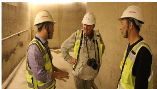
国际碾压混凝土专家检查碾压混凝土施工质量
