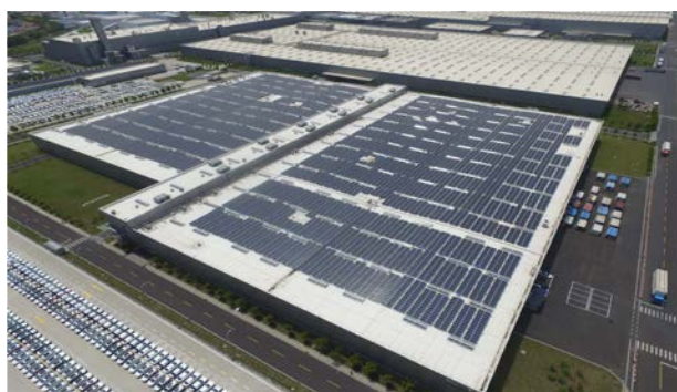
东方雨虹经典工程 ——奇瑞捷豹路虎发动机车间屋面防水
