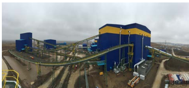
阿克托盖铜矿选厂全景
