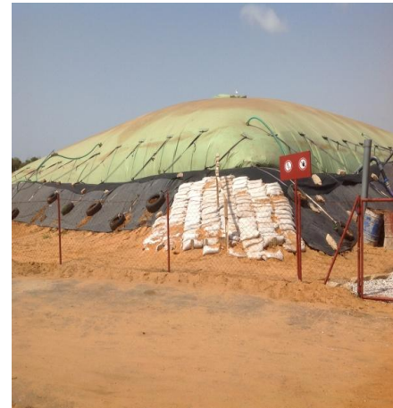
Digesteur rempli de biogaz
