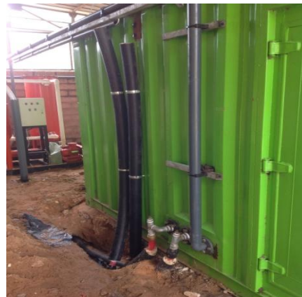
Circuit eau chaude en cours de connexion avec le PCCE
